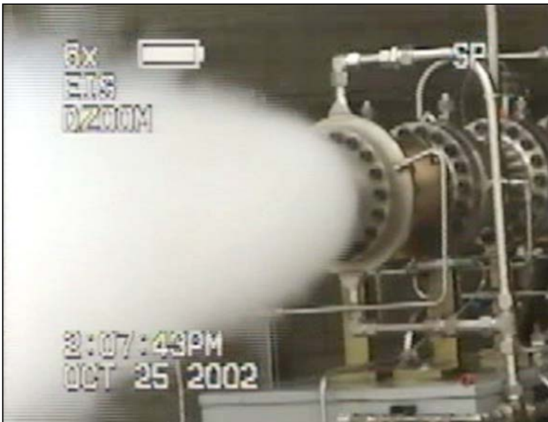
CES 20 MW t Gas Generator – 1500 psi & 1500 °F
